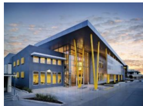
Строительство / реконструкция школы
